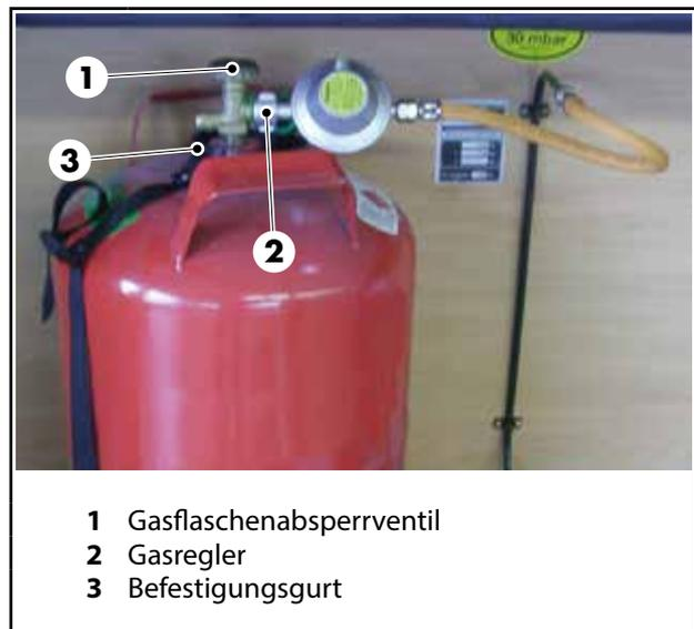
Abb. 46 Gasflasche wechseln
