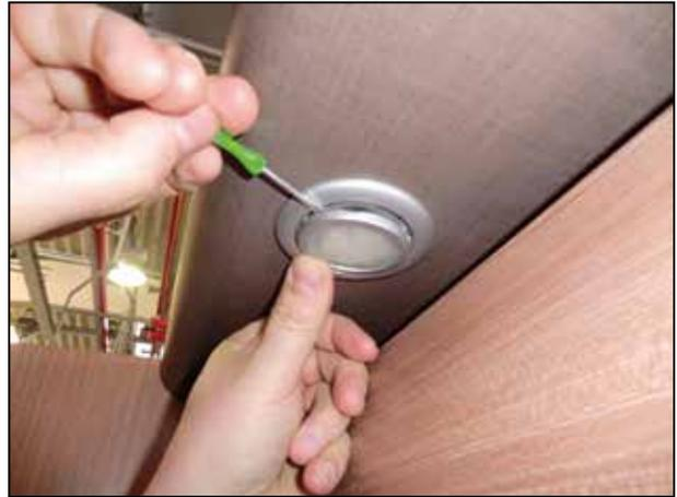
Abb. 90 Lampenwechsel am Einbauspot
